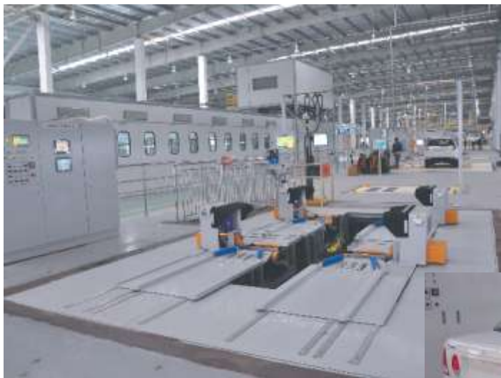
建设中的汽车总装检测线
