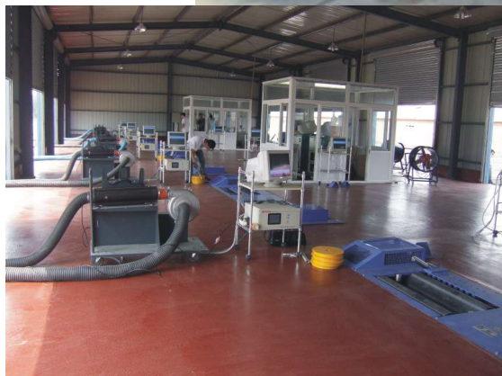
公司承建的VMAS排放检测站
